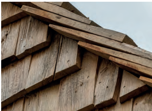
De shakes zijn in drie lagen met rvs-nagels vastgeschoten.
